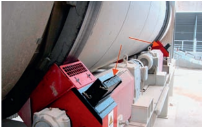
Bild 4: Montage von Verschleißschutz mit Haftblöcken beim Reibradantrieb.
